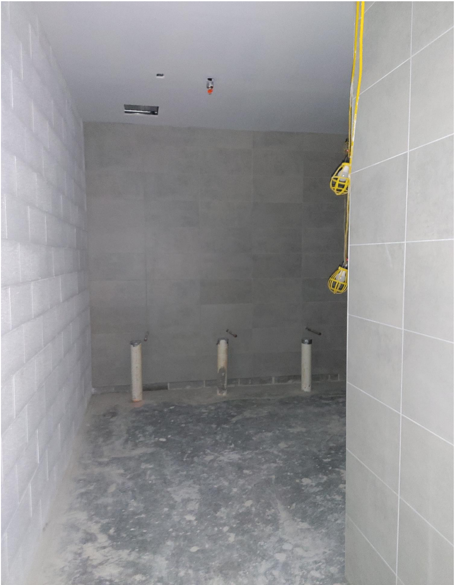
Photo 6 - Girls Locker Room - E104
